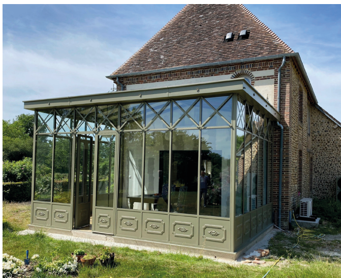
Une véranda acier réalisée et posée par Steel Créations dans les environs de L'Aigle.
