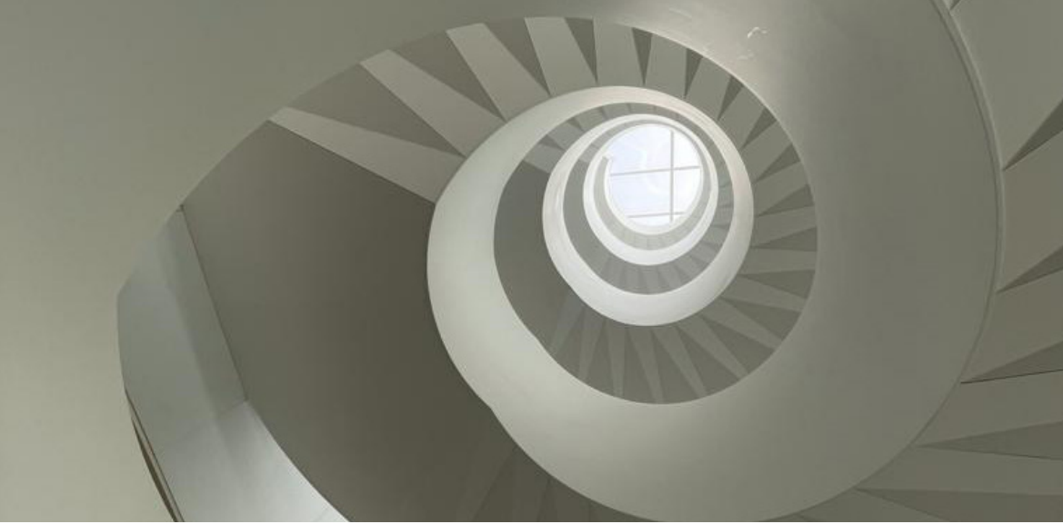
Bild: © Staalservice Hardenberg Detail der Spindeltreppe im Royal Flora Holland
