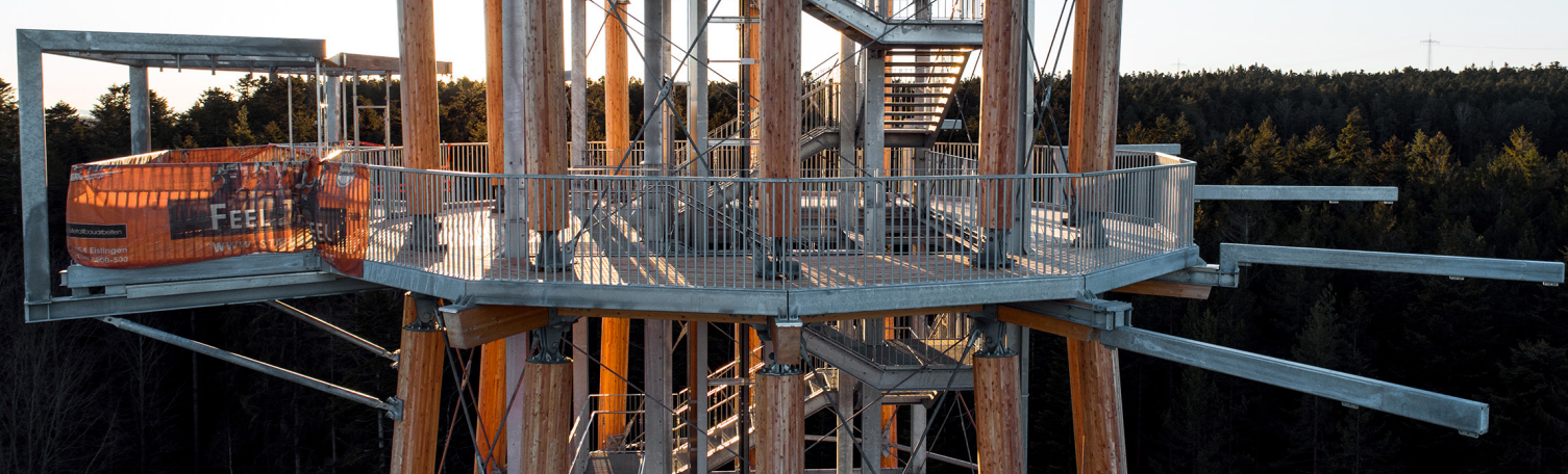
Bild: Umlaufende Rechteckrohre mit statischer Funktion
