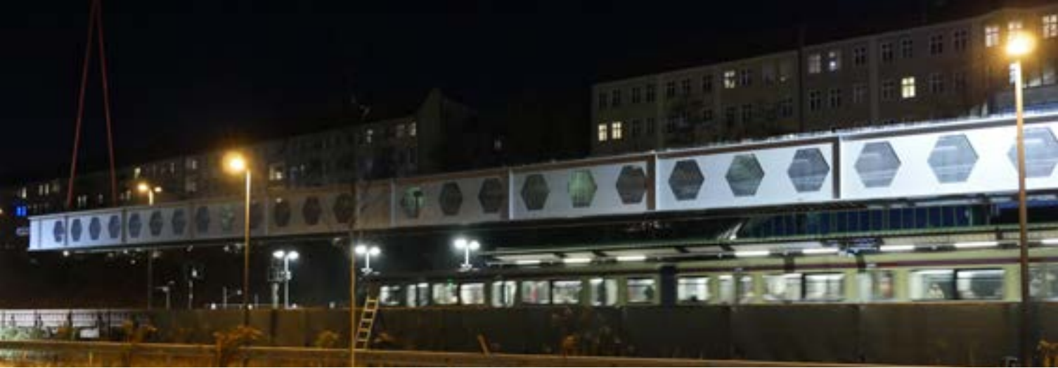
Endmontage einer Rohrbrücke über den Bahnanlagen der DB Netz AG (©IBG)
